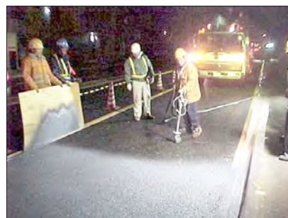
تصویر ۵: استفاده از پوشش‌های تیتانیوم برای تصفیه‌ی هوا در جاده‌ها
