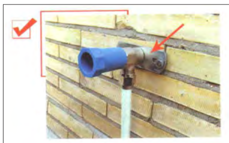
تصویر ۵: صفحه‌ی نصب بست مخصوص (شابلون) برای زانویی دیواری
