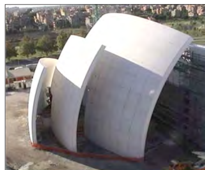
تصویر ۶: نمایی از کلیسای Dives در MISERICORDIA ساخته‌شده با سیمان دارای قابلیت خودپاک‌شوندگی
