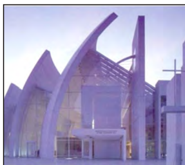
تصویر ۶: نمایی از کلیسای Dives در MISERICORDIA ساخته‌شده با سیمان دارای قابلیت خودپاک‌شوندگی
