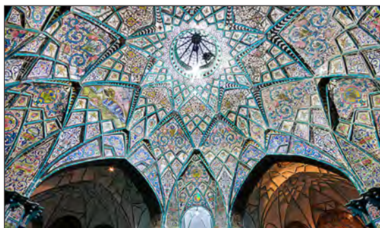
تصویر ۶: تزیینات سقف گرمابه‌ی تاریخی چهارفصل اراک
