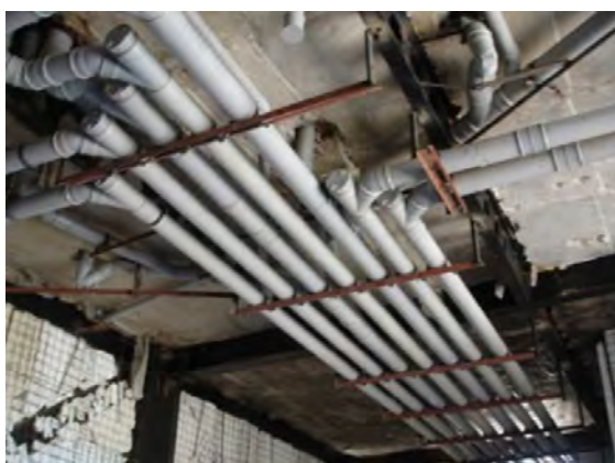
تصویر ۳: نمونه‌ای از اجرای لوله‌کشی فاضلاب و آب باران در زیر سقف، همراه با ساپورت‌گذاری مناسب
